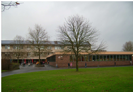
Schule mit Mehrzweckhalle
