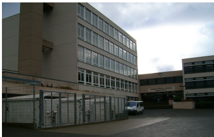
Schulgebäude mit HHS-Containern
