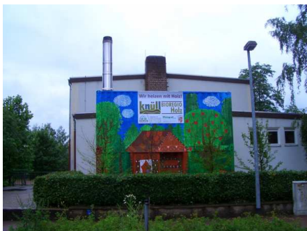
Brennstofflager im Doppelcontainer
